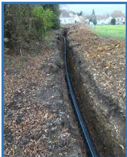
Travaux de rénovation de la canalisation d'eau potable permettant à la commune de se raccorder au réseau de Buchelay en cas de nécessité.
