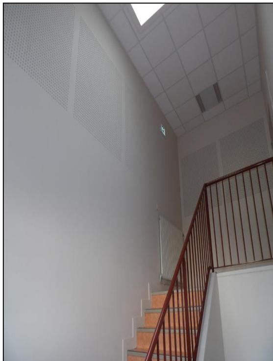
Le transfert de la classe du RDC à l'étage de la mairie a nécessité l'isolation phonique de la montée d'escalier.
