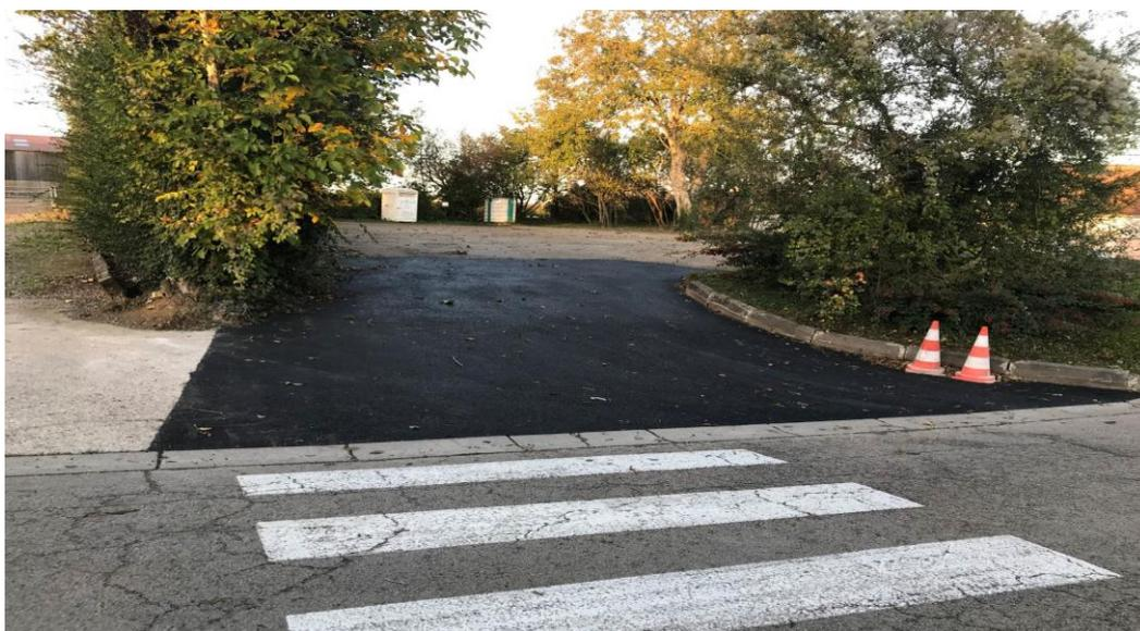
Après la plantation au printemps d'une bordure d'arbustes au long de la RD 110, le parking de la route de Fontenay a pu être agrandi, une couche de « grave » y a été étalée pour surfacer l'ensemble, et la voie d'accès depuis la route de Fontenay revêtue d'un enrobé.
