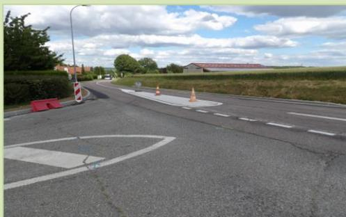
Les marquages au sol initialement réalisés sont désormais remplacés par de petits terre-pleins en bitume revêtus de pavés en résine.
